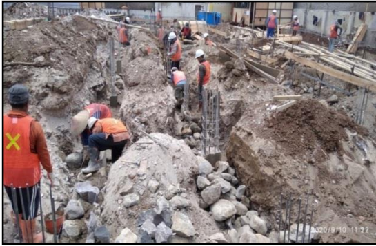
Gambar 3.2 Kegiatan Proyek Pembangunan Gedung Perkantoran KPU
