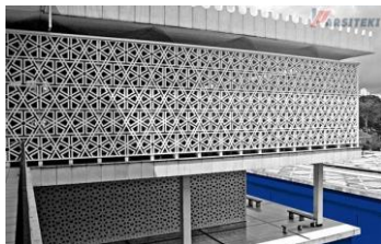
Gambar 5 Roster beton pada bangunan
