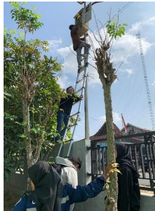
Gambar 1. Kegiatan Identifikasi Kondisi Solar Panel (Dokumentasi Pribadi)
