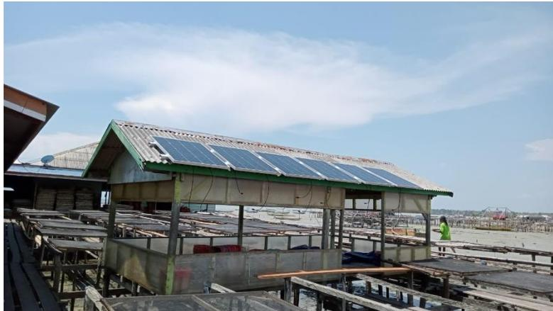
**Gambar 6.** Atap panel surya untuk operasional rumah pengering *hybrid*
