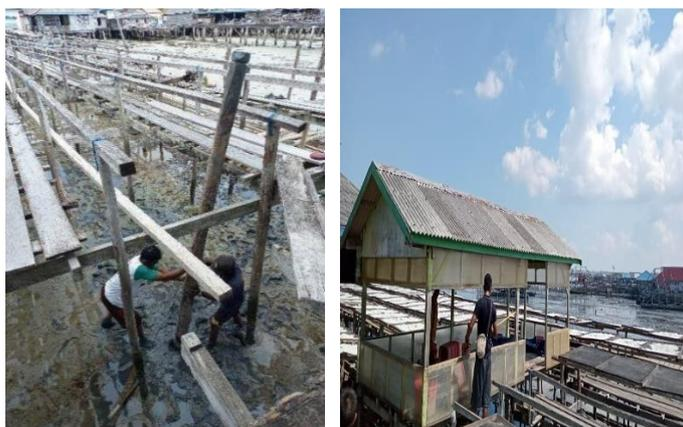
**Gambar 5.** Proses pembuatan rumah pengering *hybrid* dengan tipe *shed roof*
