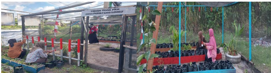
Gambar 7. Merenovasi rumah TOGA PKK
