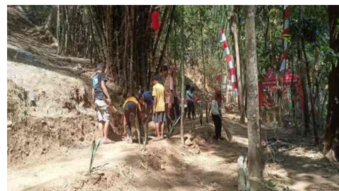
Gambar 6. Hasil Pelebaran jalan
