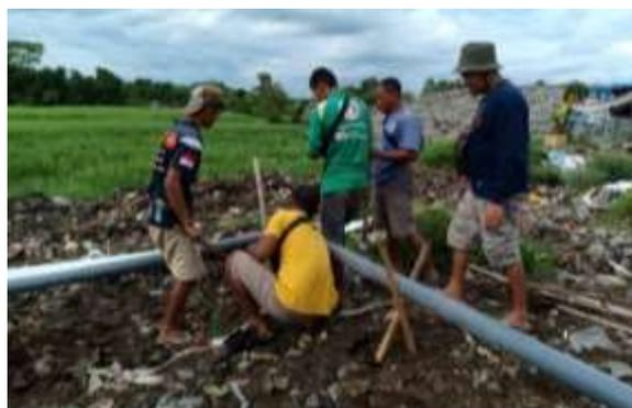
**Gambar 5.** Pemasangan Saluran Distribusi Biogas
