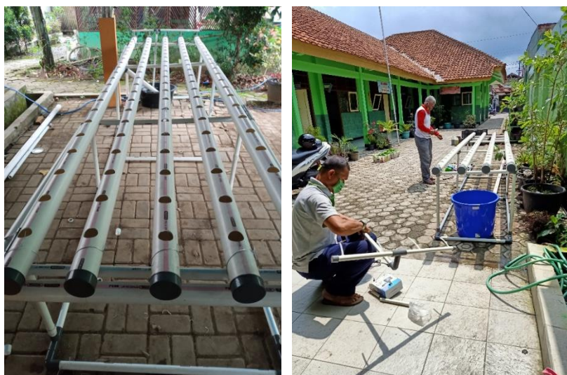
Gambar 2. Pemasangan Instalasi Hidroponik
