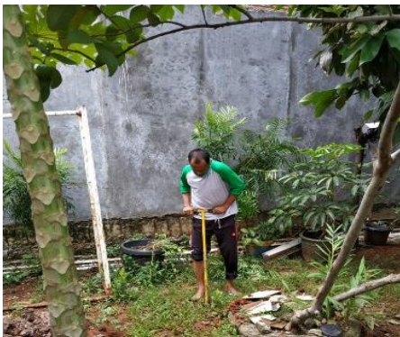
Gambar 2. Pembuatan Lubang Biopori
